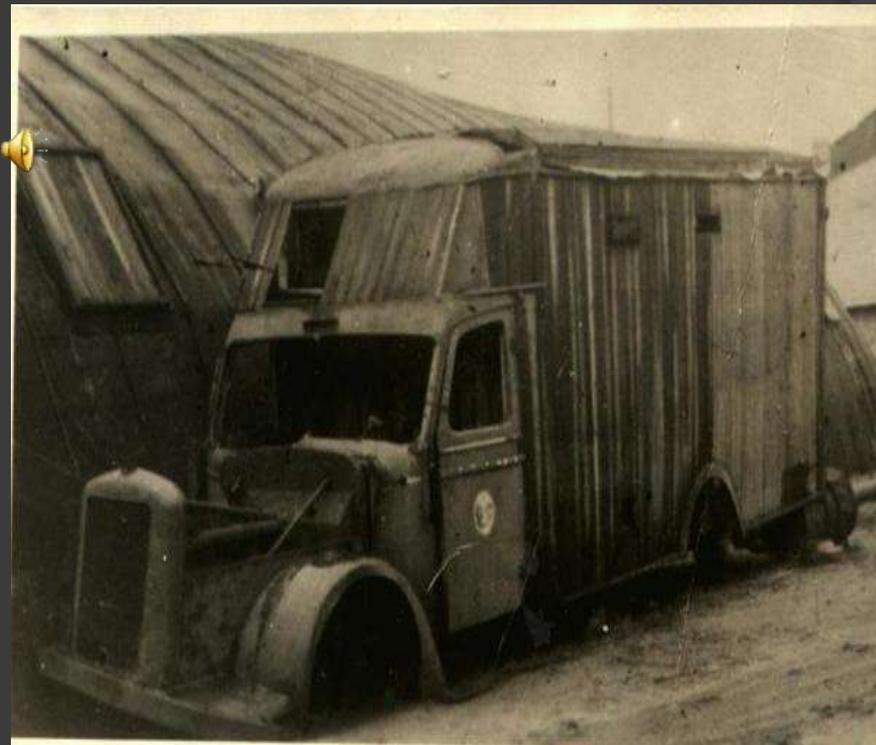
**«Душегубкой» назывался немецко-фашистский газовый автомобиль «Газваген». Его устройство представляло собой мобильную газовую камеру на колесах, в которую через шланг выпускали отравляющий газ. Кузов без окон, обивка - оцинкованное железо. Их часто можно было встретить в районе современного Сенного рынка.**
